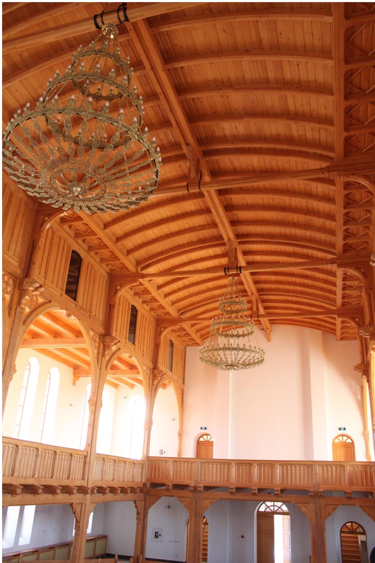
Общий внутренний вид церкви и отдельных частей деревянных конструкций.
