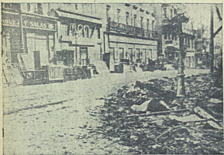
На снимке: одна из центральных улиц Мадрида, разрушенная бомбами фашистской авиации.
