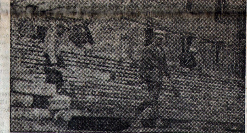
На строительстве немедицинского института в гор. Энгельсе. На снимке: Бригада каменщиков Зайцева за работой. (Ф. Вильгельми)
