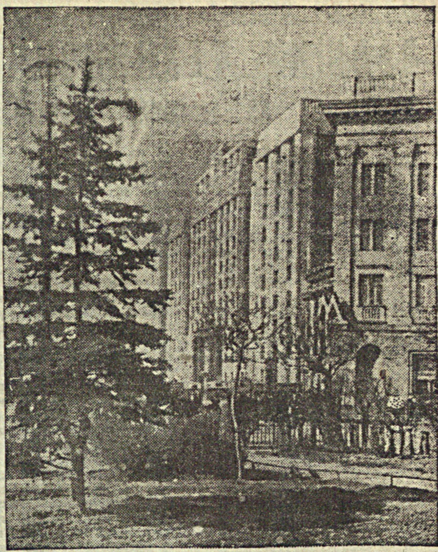
Новая Москва. На снимке: вид на станцию метро «Площадь им. Свердлова», и здание Совнаркома СССР в Охотном ряду со стороны сквера у Большого театра.
