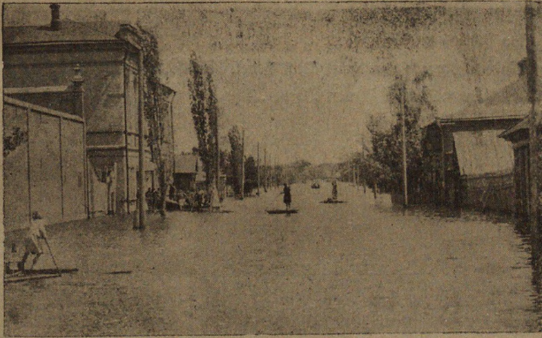
Die Rowousenker Straße in Volkrowsk unter Wasser.
