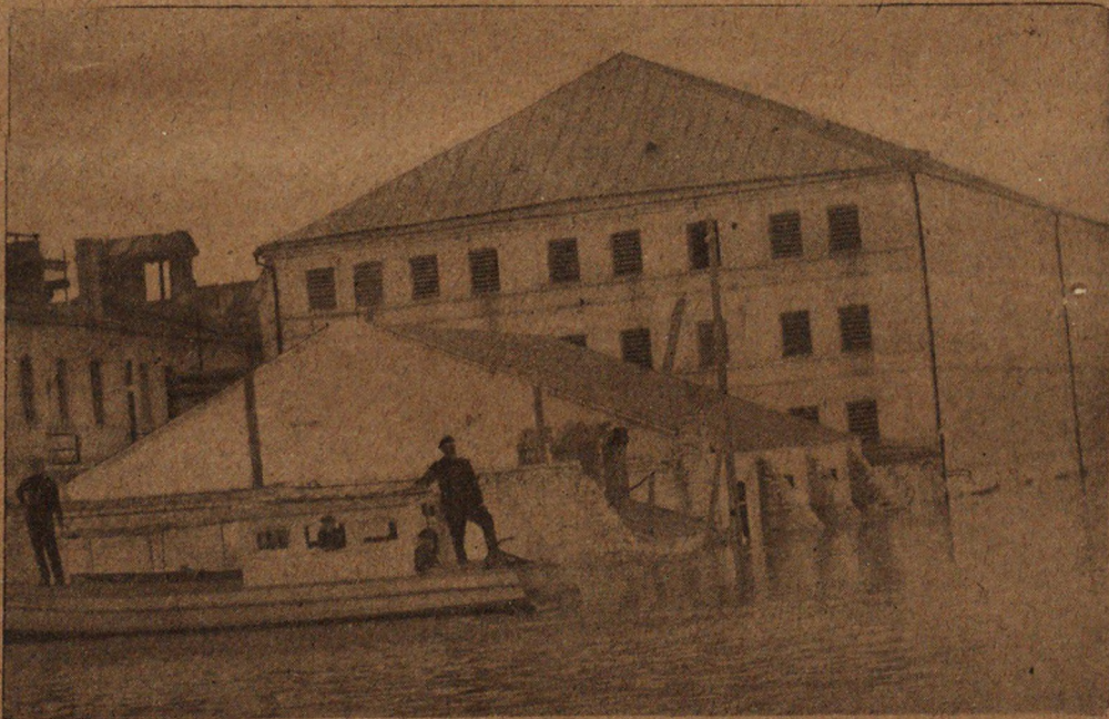
Die Knochenfabrik am 30. Mai (während des höchsten Hochwasserstandes).
