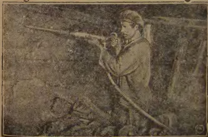
SCHACHT „AMERIKANKA“. — Unser Kohlenbergbau wird mechanisiert. Unser Bild zeigt einen Druckluftbohrer, der allein mehr leistet als viele Häuer (Arbeiter, die die Kohlen losschlagen)
