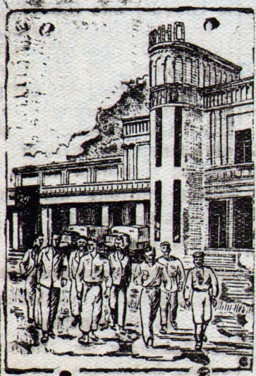
Die Schichtarbeiter am neu erbauten Kinotheater.
