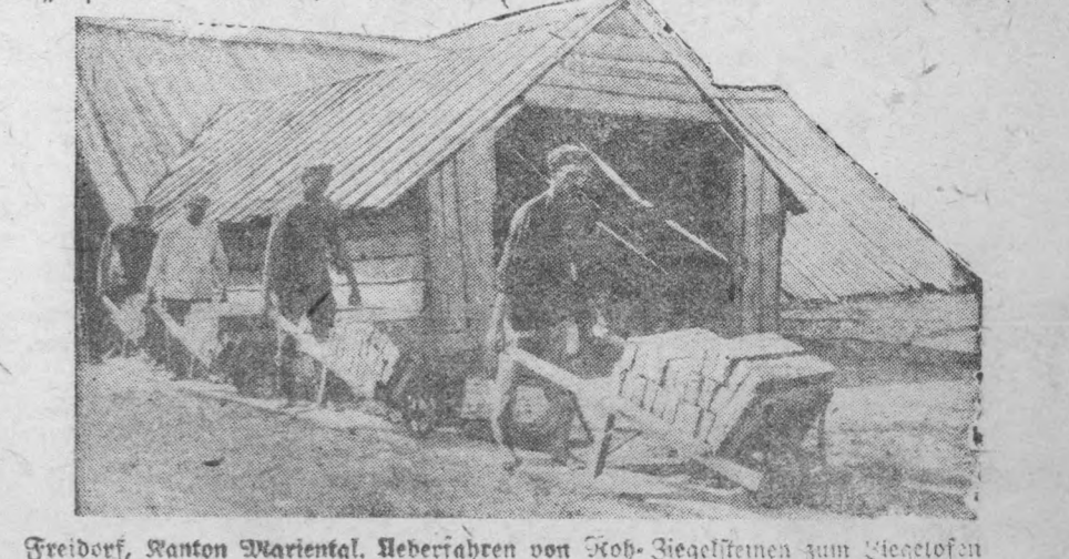
Freidorf, Kanton Mariental. Heberfahren von Hoch-Ziegelsteinen zum Kesselstein.
